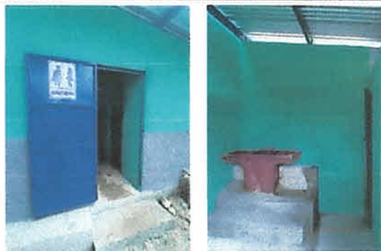
FOTO 6: RECONSTRUCCIÓN DE PARED, CAMBIO DE PENDIENTE Y COLOCACIÓN DE LÁMINA CON SU ESTRUCTURA DE METAL.
