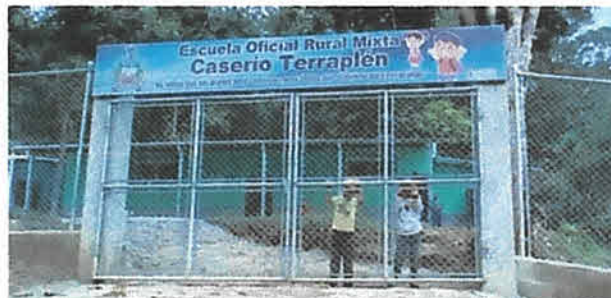
FOTO 2: INSTALACIÓN DE PORTÓN DE DOS HOJAS CON TUBO GALVANIZADO Y MALLA.
