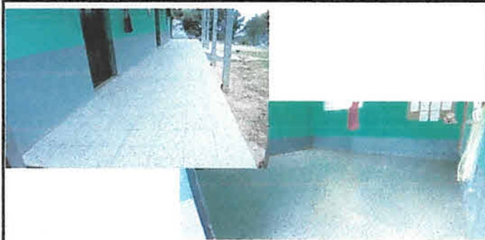
FOTO 3: SE CULMINÓ LA INSTALACIÓN DEL PISO DE GRANITO EN LAS DOS AULAS Y EN EL CORREDOR.
