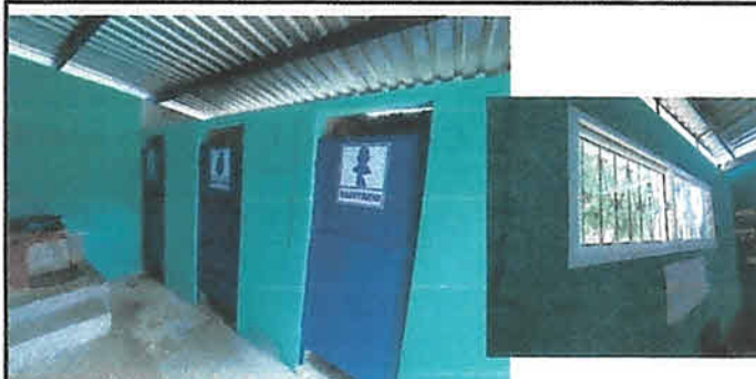
FOTO 4: MANTENIMIENTO DE PUERTAS DE SERVICIOS SANITARIOS Y COLOCACIÓN DE VENTANAS PVC EN AULAS.
